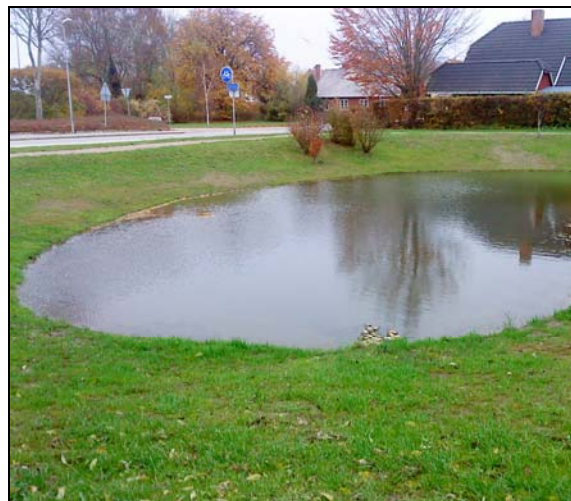
Regnvandsbassin i Voldum.
